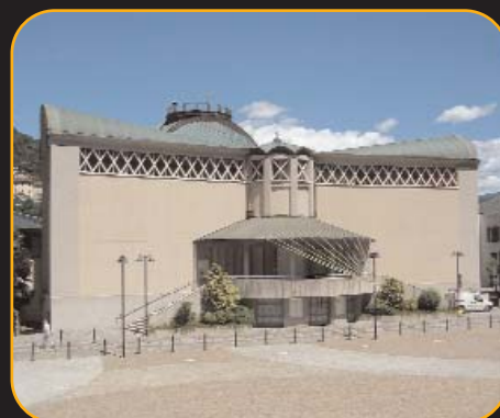
Chiesa S.S. Crocifisso Ponte Tresa (Varese)
